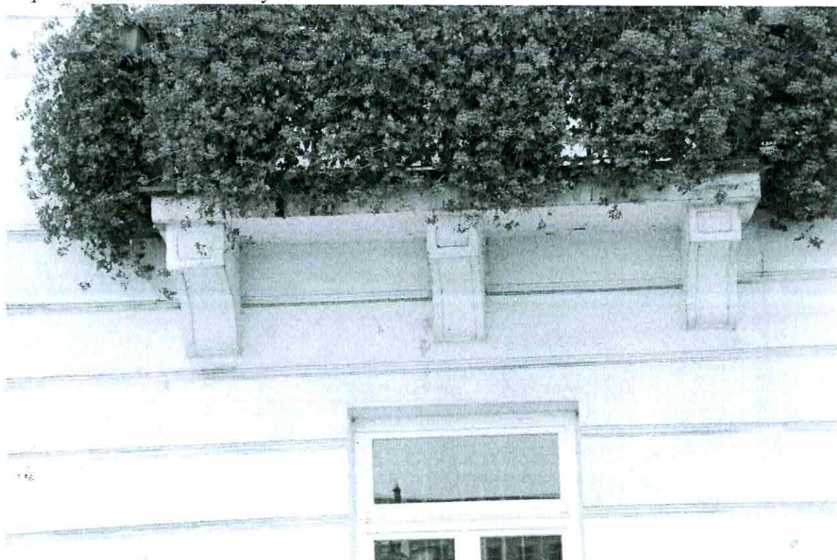
elementy gzymsu – stan dobry
